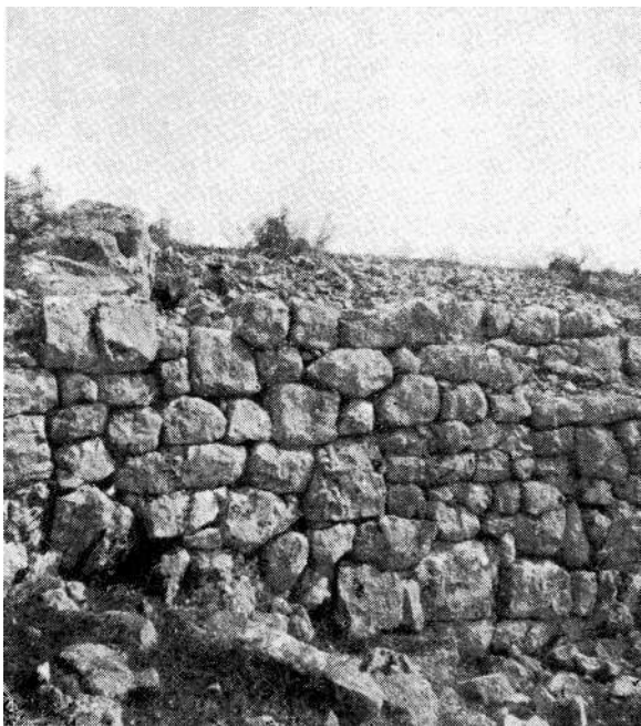
Sl. 9. Sjeverozapadni zid zgrade G. Na ovom je mjestu ostao najbolje sačuvan primjer zidanja po sistemu »oplate«. — Nordwestliche Mauer des Gebäudes C mit der charakteristische Bauart.
