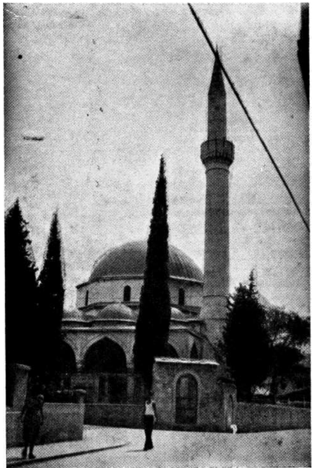
Karadobzegovaa džamija u Mostaru nakon skidanja dogradnje (foto Dž. Čelić, 1952)
