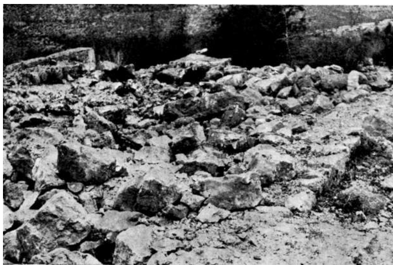
Sl. 33. Temelji i ruševine crkve, pogled sa sjeveroistočne strane.
